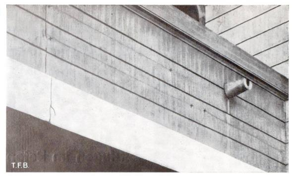
Abb. 1 Rissbildungen und Verschiebungen in Eisenbeton-Träger
