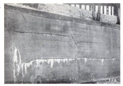
Abb. 2 Wasseraustritte und Ausblühungen in Stützmauern
