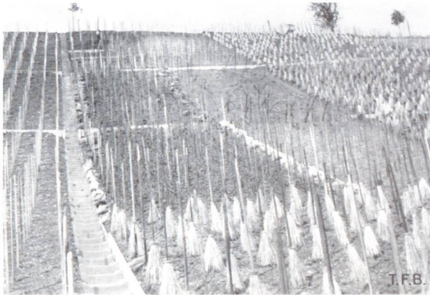
Abb. 4 Rekonstruierter Rebberg mit Wassertreppe (Modell Teufen) zwei Lager Schwemmbretter, Reben teilweise m. Frostschirmen geschützt
