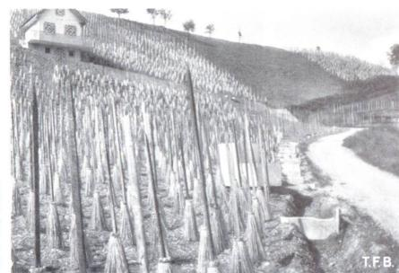
Abb. 5 Rekonstruierter Rebberg, Anfall- und Seitengraben kombiniert, mit Querbrettern in verschiedene Absetzbecken unterteilt. Doppelspritztrog
