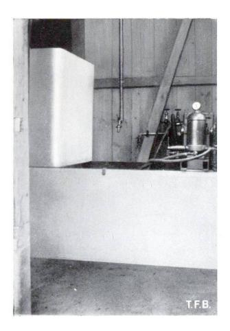
Abb. 7 Blick in Pumpenhaus einer zentralen Spritzanlage, armierte Betonspritztröge, 3 aufeinander, lediglich 2 sichtbar
