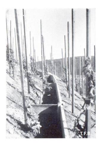
Abb. 3 Schwemmgraben mit armierten Betonschwemmbrettern gesichert, Unterteilung mit Querbrettern zur Erhöhung des Fassungsraums der Graben für Schwemmaterial
