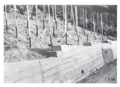
Abb. 1 Futtermauer, horizontal abgetreppt wegen des Anfallgrabens, mit Betonquerbrett als Abschluss. Ring in Mauer (eingelassen) zur Befestigung der Ketten für Umleitrolle bei mechanischer Bewirtschaftung
