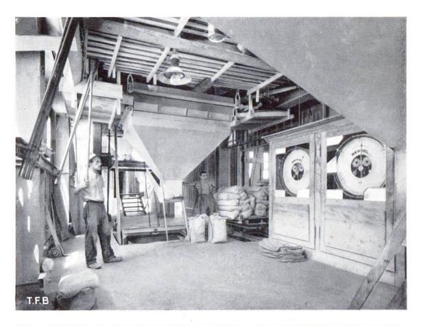
Abb. 4 Abwägen der Betonbestandteile gewährleistet die vorgeschriebene Cementdosierung. (Photo in entgegenkommender Weise von der Arbeitsgemeinschaft Maschinenhaus Kraftwerk Wildegg-Brugg zur Verfügung gestellt)
