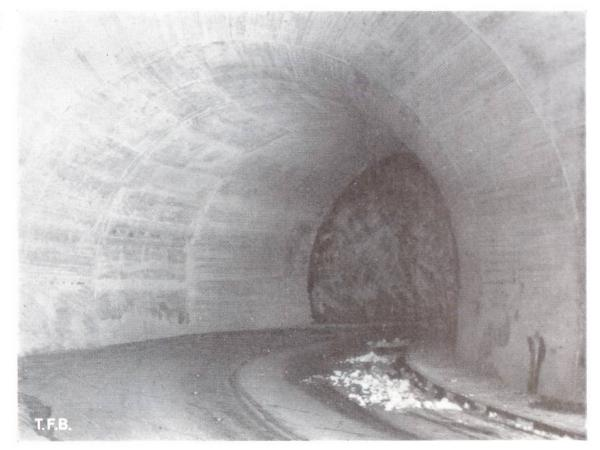
Abb. 3 Nur teilweise betonierter Strassentunnel, im Hintergrund roher Felstunnel, deutlich sichtbar ist der Helligkeitsunterschied
