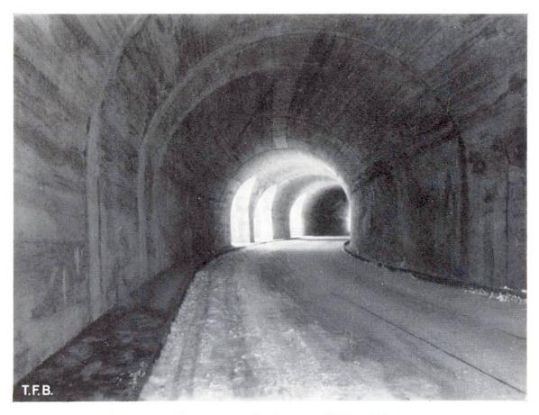
Abb. 2 Langer, betonierter Strassentunnel mit guten Sichtverhältnissen
