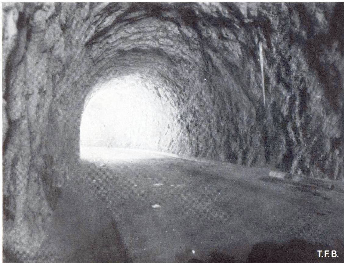
Abb. 5 Roher Felstunnel mit Eiszapfenbildung
