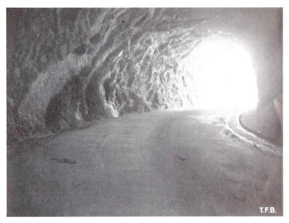
Abb. 4 Roher Felstunnel, störende Helligkeitsunterschiede und Schlagschatten
