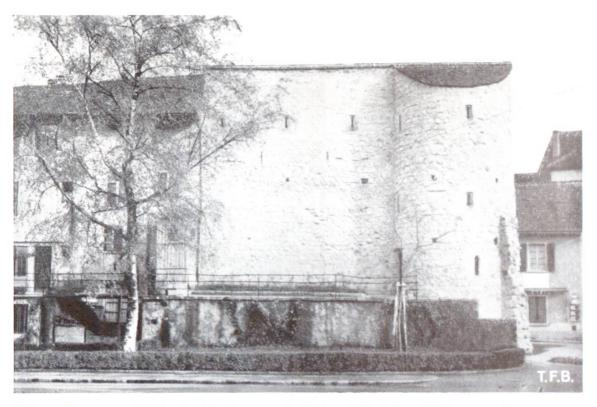
Abb. 4 Fugengemörteltes (1950) Mauerwerk. Frühes Mittelalter. Wehrmauer Brugg
