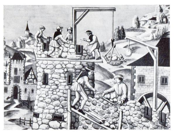
Abb. 2 Mittelalterliche Bautechnik. Ausschnitt aus einem Fresko im Klostersaal zu Stein am Rhein
