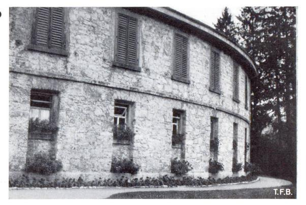
Abb. 6 Bruchsteinmauerwerk aus der Neuzeit. Bad Schinznach
