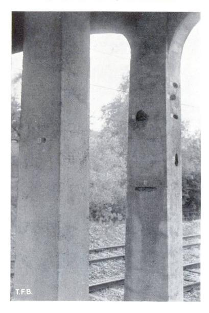
Abb. 6 Schäden bei Eisenbetonsäulen, durch poröse Stellen angezeigt
