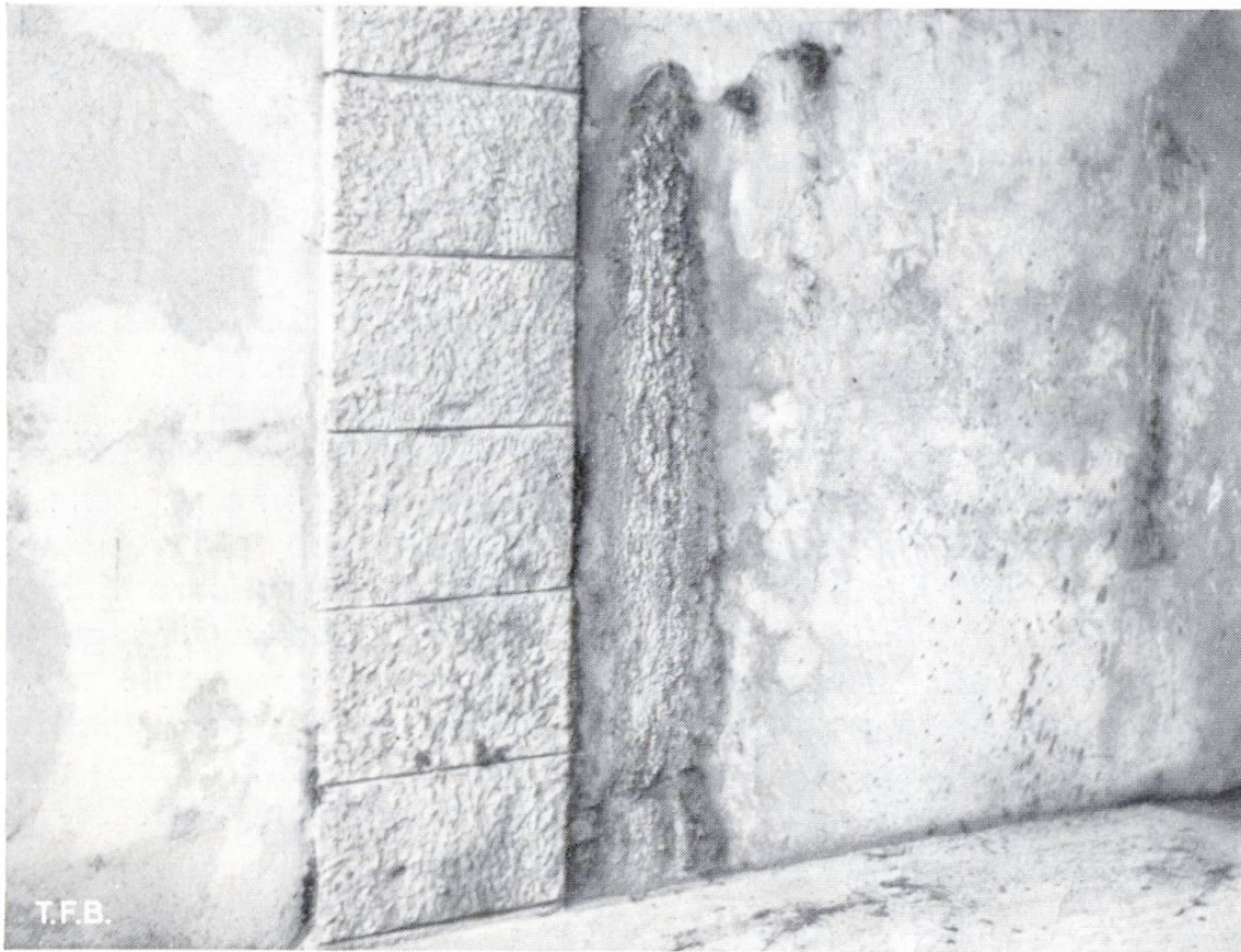
Abb. 5 Auswaschungen von Cement bei einem Widerlager durch eine poröse Stelle - Ungenügende Isolierung der Rückflächen
