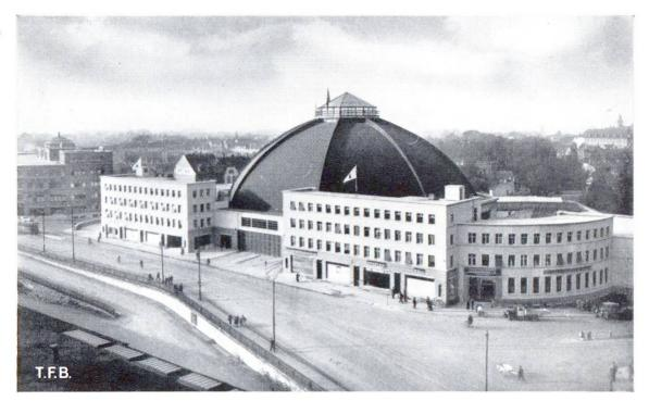
Abb. 2 Grossmarkthalle Basel - Anwendung der Schalenbauweise
