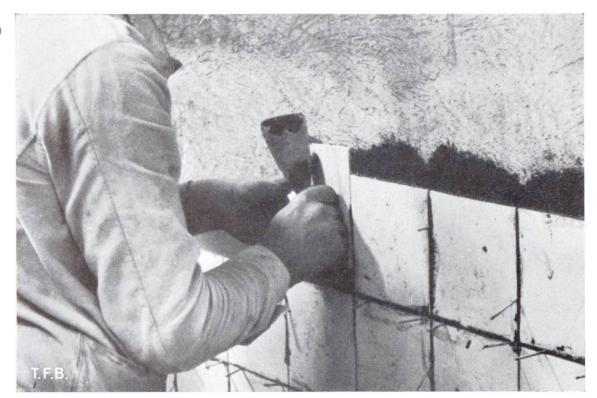
Abb. 5 Versetzen von Wandplatten nach dem Klebeverfahren
