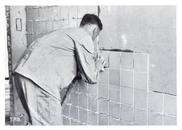
Abb. 6 Die letzte Platte einer Reihe wird zurechtgerückt. Man beachte die Sicherung einer gleichmässigen Fugenweite
