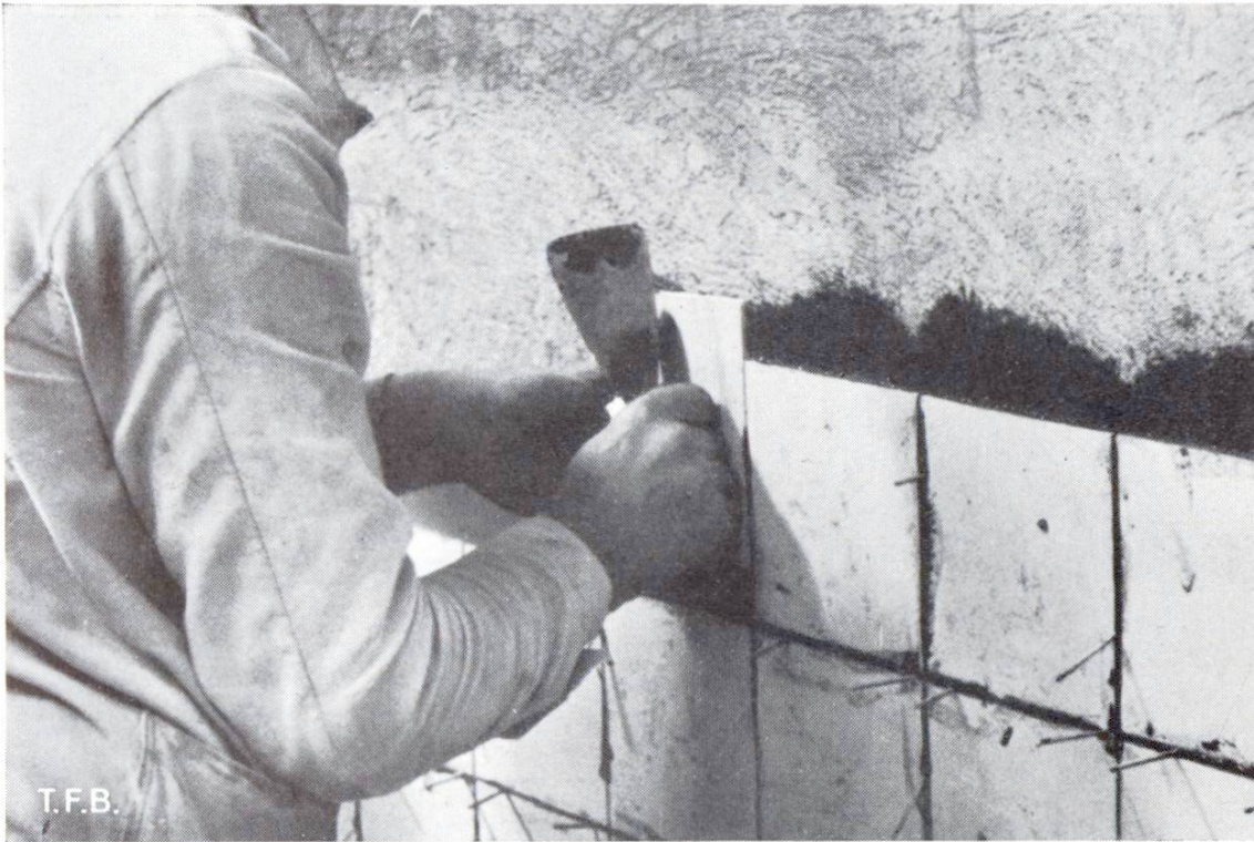
Abb. 5 Versetzen von Wandplatten nach dem Klebeverfahren
