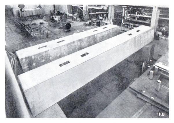
Abb. 4 Zwei fertige Decken-Schutzbalken über der Synchrocyclotron-Kammer
