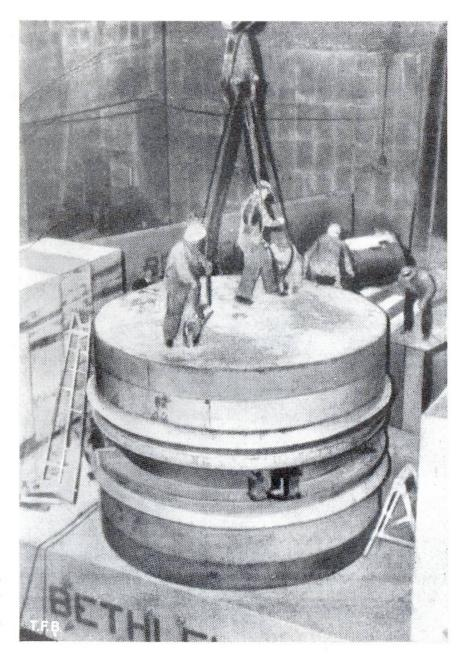
Abb. 7 Strahlenschutz für eine Atomzertrümmerungsanlage aus Eisenbeton (~ 2500 Tonnen schwer)
