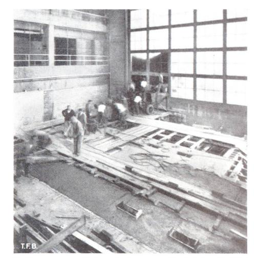
Abb. 5 Giessen eines Balkens zwischen zwei fertigen Balken. Die Aussparungen in der Kopffläche sind Greiflöcher, in denen die durchgehenden Ankerbolzen sichtbar sind
