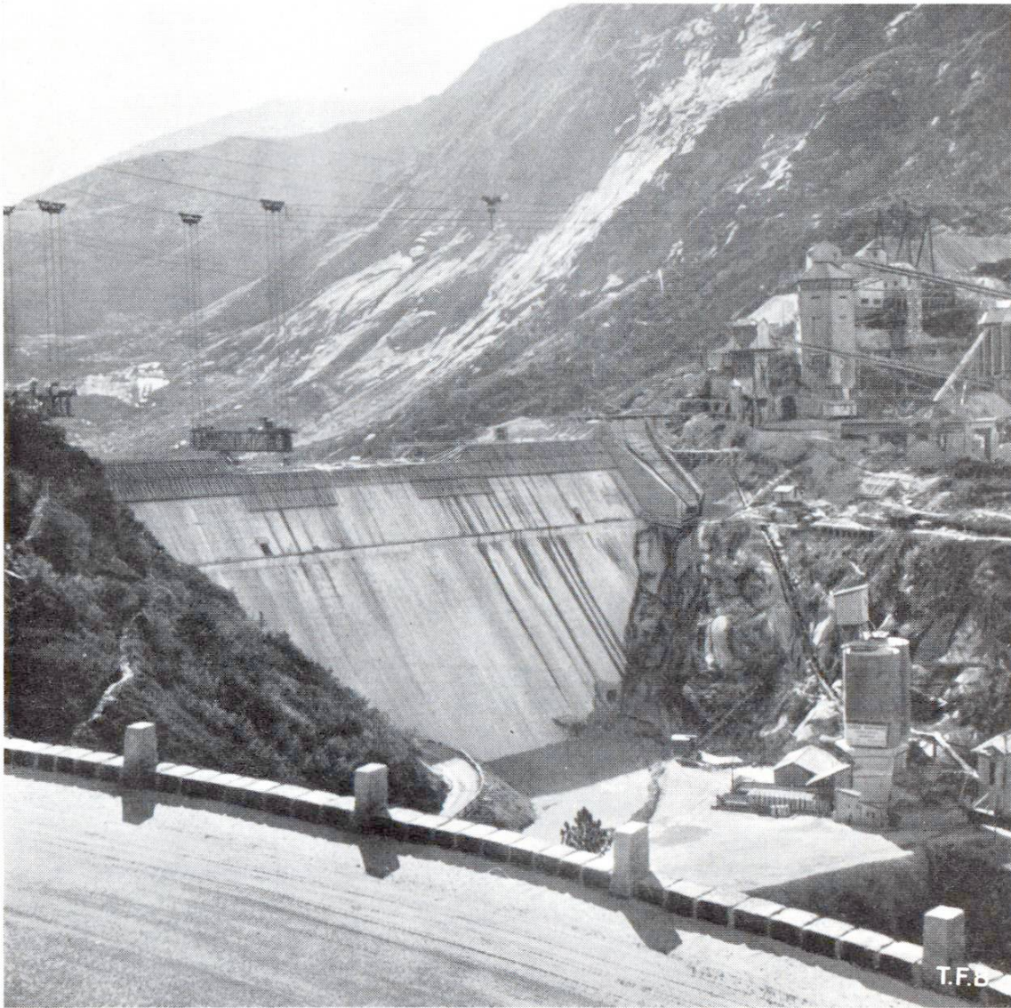
Abb. 5 Staumauer Räterichsboden. Rechts unten: Cementsilos mit 2000 Tonnen Inhalt, rechts oben: Betonaufbereitungsanlage
