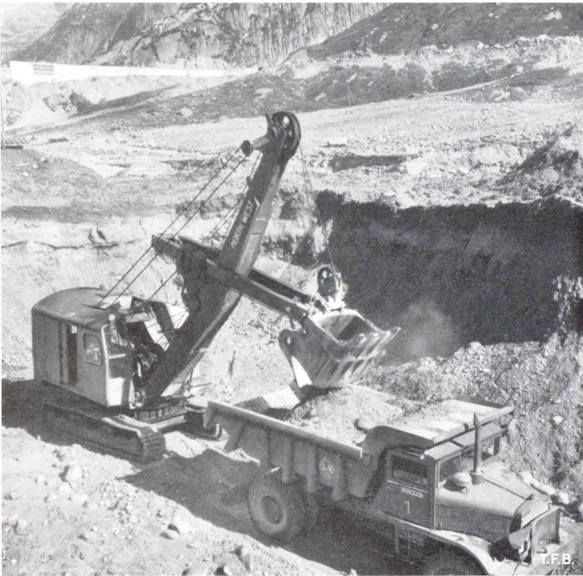
Abb. 1 Kiesbaggerung im Rätherichsboden. Der schwere Euklid-Lastwagen (8 m 3 fassend) fährt das Material zur Vorsortierung und Brechanlage, wo die grossen Steine (über 18 cm \varnothing ) zerkleinert werden.
