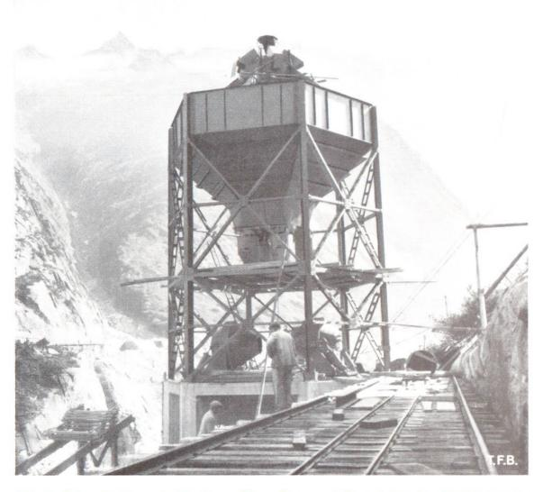
Abb. 3 Betonmischturm in Montage. Oben Kies- und Cementsilos (aus Blech) darunter automatische Wagen. Unten 2 Betonmischmaschinen
