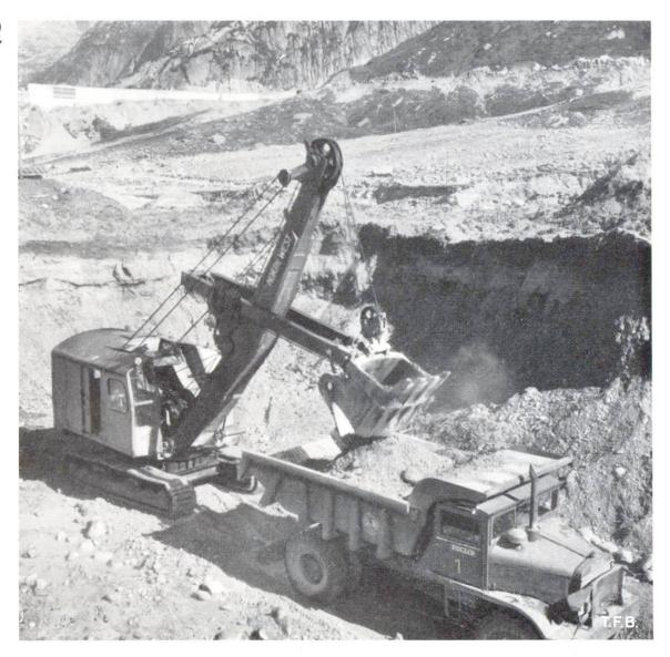
Abb. 1 Kiesbaggerung im Rätherichsboden. Der schwere Euklid-Lastwagen (8 m³ fassend) fährt das Material zur Vorsortierung und Brechanlage, wo die grossen Steine (über 18 cm Ø) zerkleinert werden
