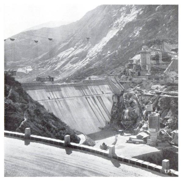
Abb. 5 Staumauer Rätherichsboden. Rechts unten: Cementsilos mit 2000 Tonnen Inhalt, rechts oben: Betonaufbereitungsanlage
