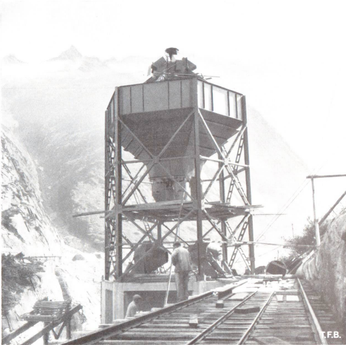
Abb. 3 Betonmischturm in Montage. Oben Kies- und Cementsilos (aus Blech) darunter automatische Wagen. Unten 2 Betonmischmaschinen
