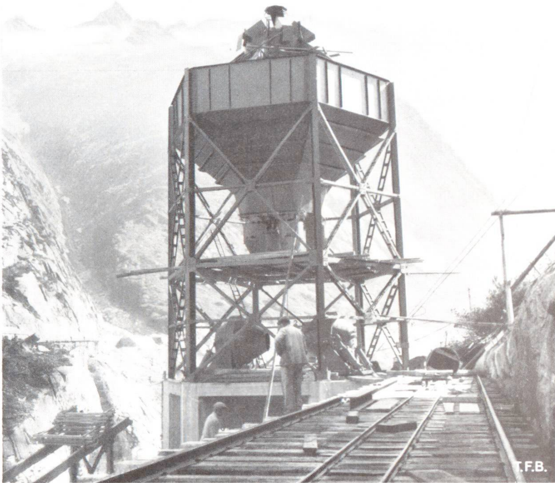
Abb. 3 Betonmischturm in Montage. Oben Kies- und Cementsilos (aus Blech) darunter automatische Wagen. Unten 2 Betonmischmaschinen
