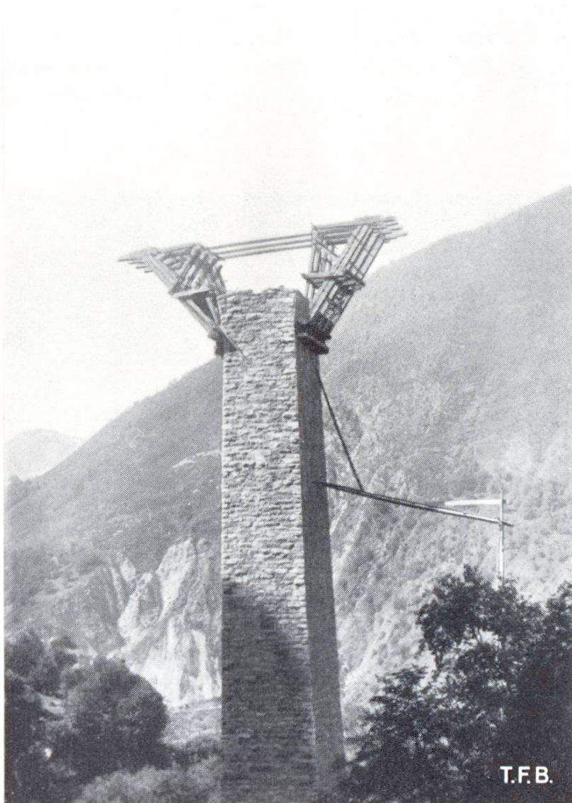
Abb. 5 Brückenpfeiler während seiner Errichtung
