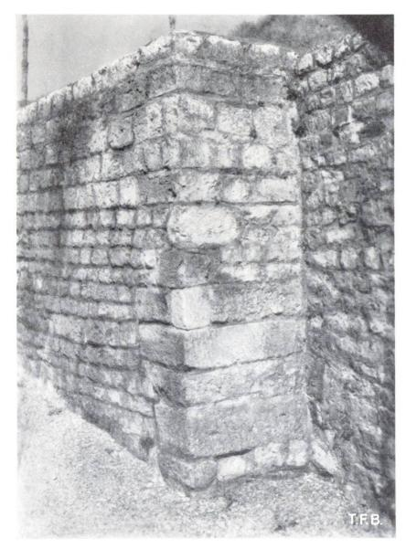
Abb. 1 Römisches Mauerwerk (3. Jahrh. n. Chr.), erbaut in hydr. Kalk
