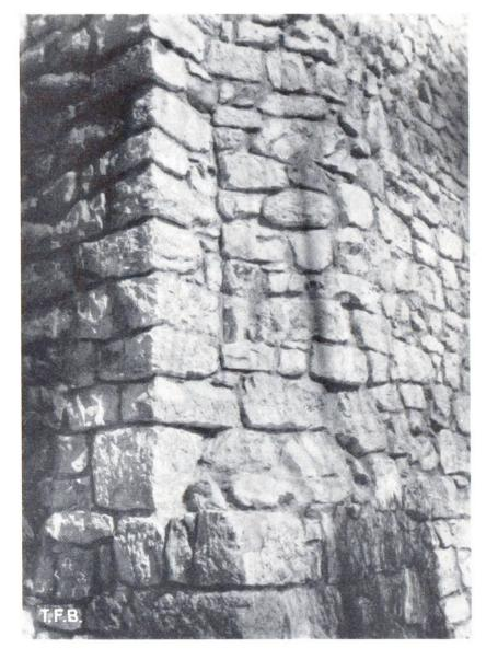
Abb. 2 Mittelalterliche Befestigungsbaute, erstellt mit hydr. Kalkmörtel
