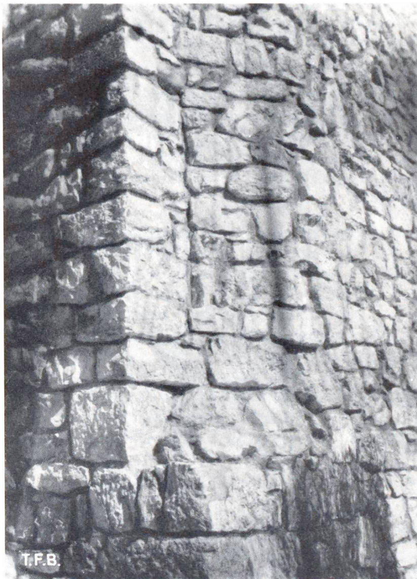
Abb. 2 Mittelalterliche Befestigungsbaute, erstellt mit hydr. Kalkmörtel
