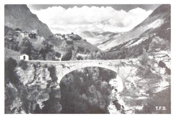
Abb. 3 Kinnbrücke, erstellt 1544-46. Mauerwerk in hydr. Kalk
