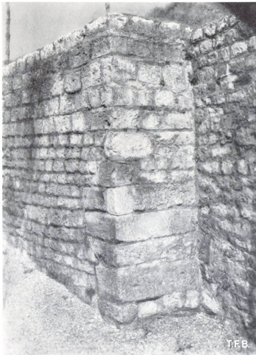
Abb. 1 Römisches Mauerwerk (3. Jahrh. n. Chr.), erbaut in hydr. Kalk
