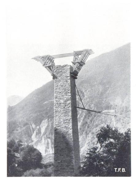
Abb. 5 Brückenpfeiler während seiner Errichtung
