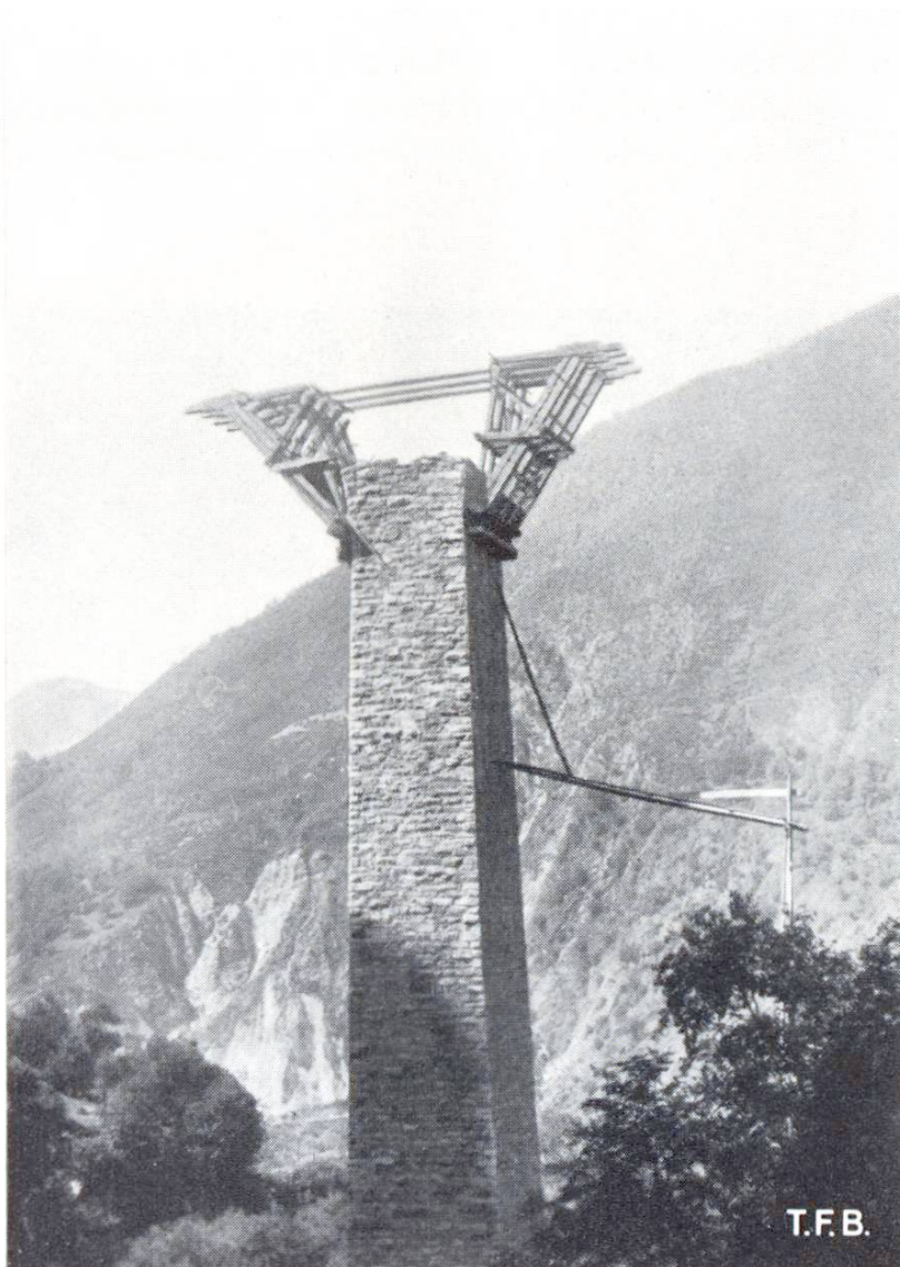
Abb. 5 Brückenpfeiler während seiner Errichtung
