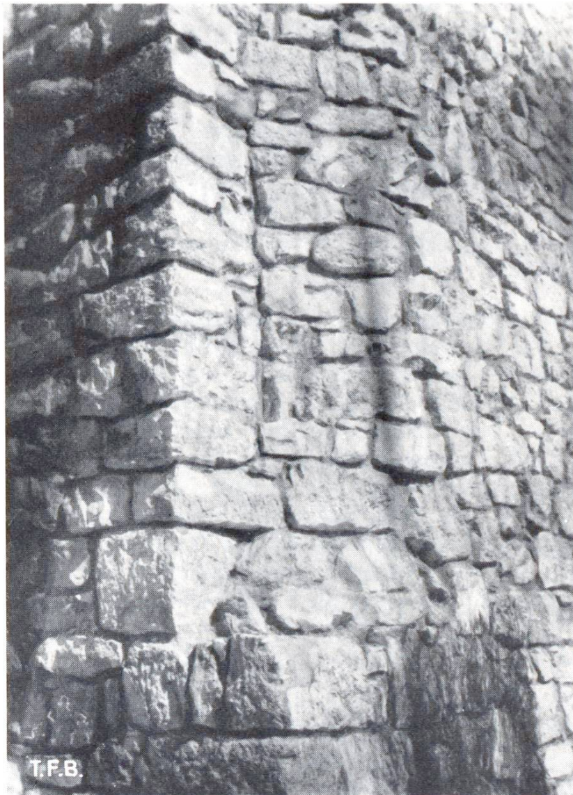
Abb. 2 Mittelalterliche Befestigungsbaute, erstellt mit hydr. Kalkmörtel
