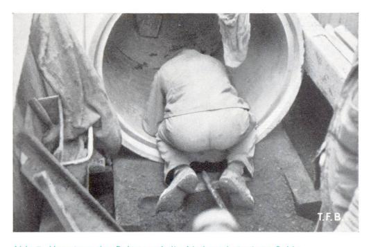
Abb. 7 Versetzen des Rohres auf die frisch vorbetonierte Sohle
