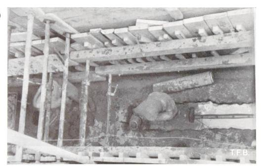
Abb. 6 Entwässerung der Grabensohle durch Sickerrohrleitung
