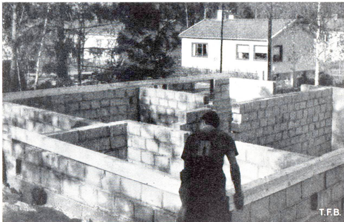
Abb. 11 Bau mit Betonhohlblöcken in einer Siedlung
