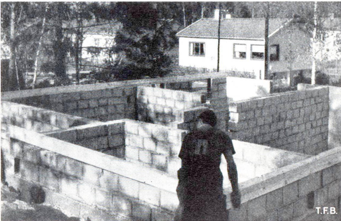
Abb. 11 Bau mit Betonhohlblöcken in einer Siedlung
