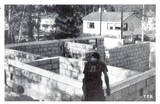
Abb. 11 Bau mit Betonhohlblöcken in einer Siedelung
