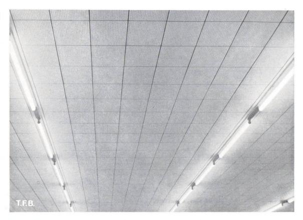
Abb. 2 Saaldecke belegt mit Akustikplatten zwecks Lärmschluckung
