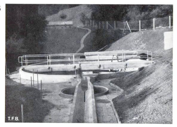
Abb. 4b Sandfang und Absetzbecken
