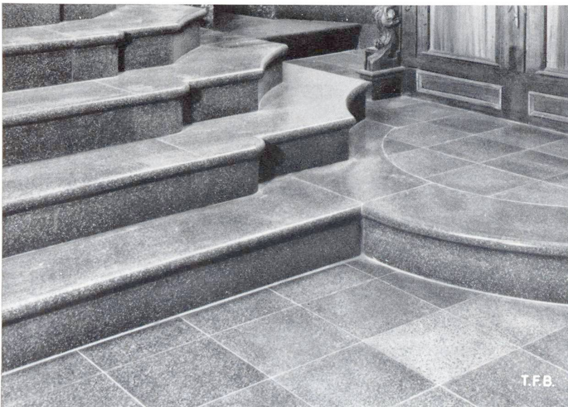
Abb. 6 Bodenbelag und Treppen aus Kunststein
