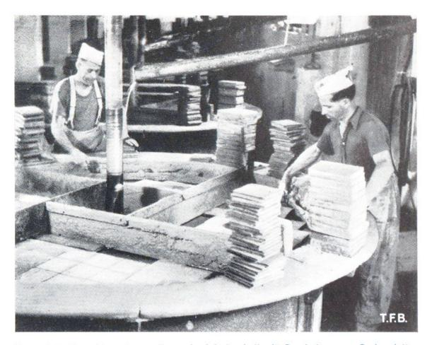
Abb. 4 Schleifmaschine mit untenliegender Arbeitsscheibe für Bearbeitung von Bodenplatten
