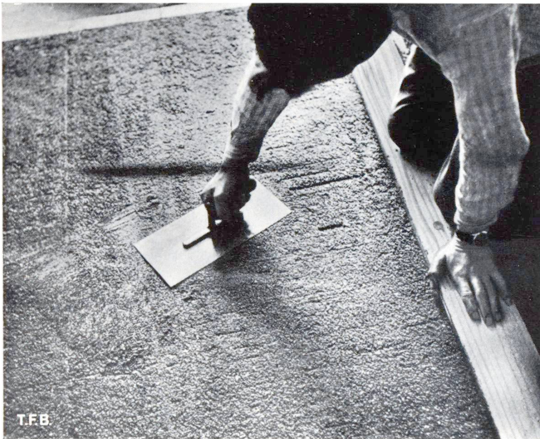
Abb. 4 Abglätten des Ueberzugs mit der Stahlscheibe
