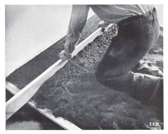
Abb. 2 Abziehen und Verdichten des verteilten Mörtels mit der Latte
