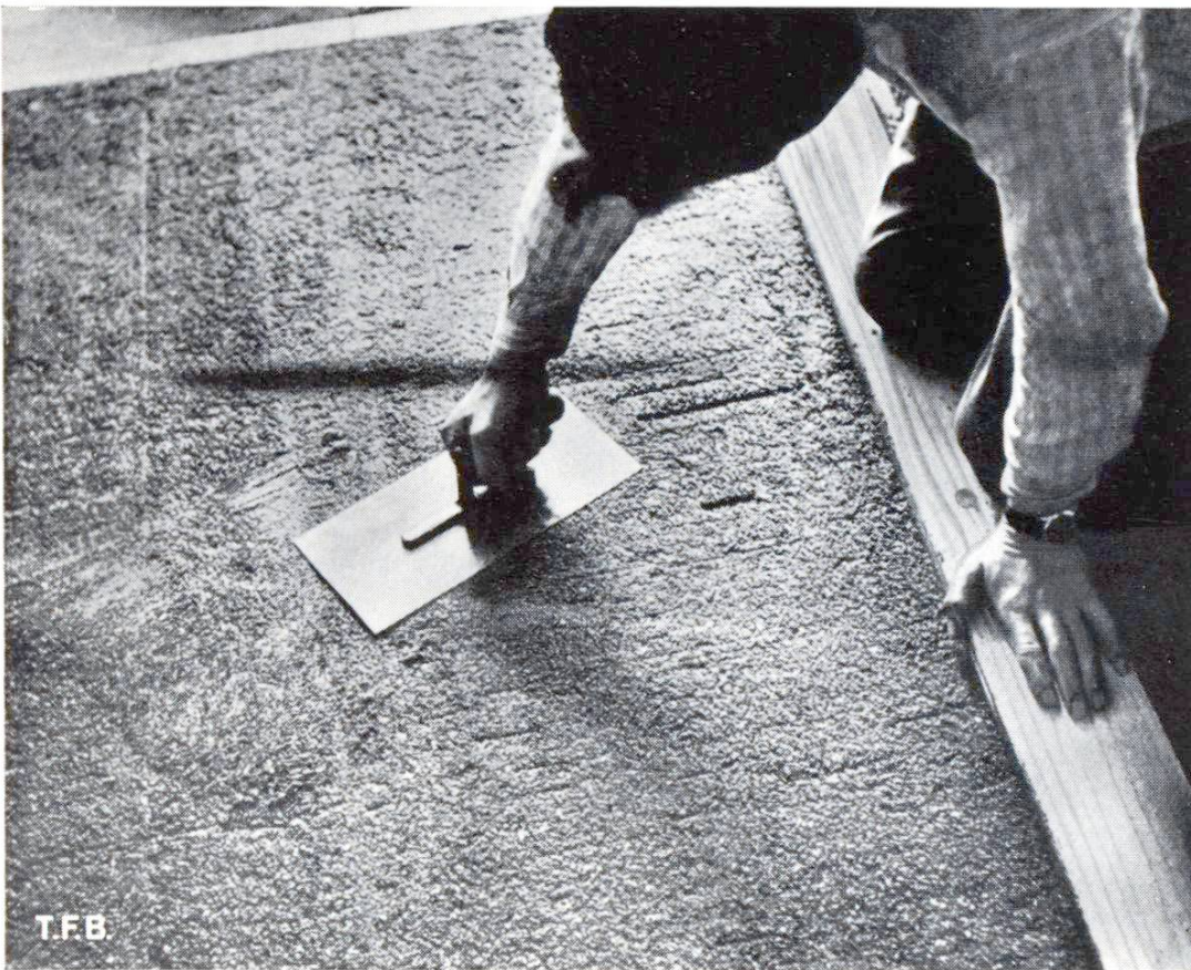
Abb. 4 Abglätten des Ueberzugs mit der Stahlscheibe
