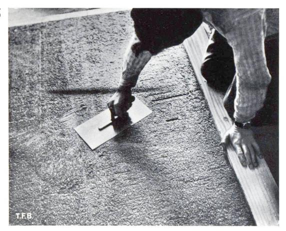
Abb. 4 Abglätten des Ueberzugs mit der Stahlscheibe
