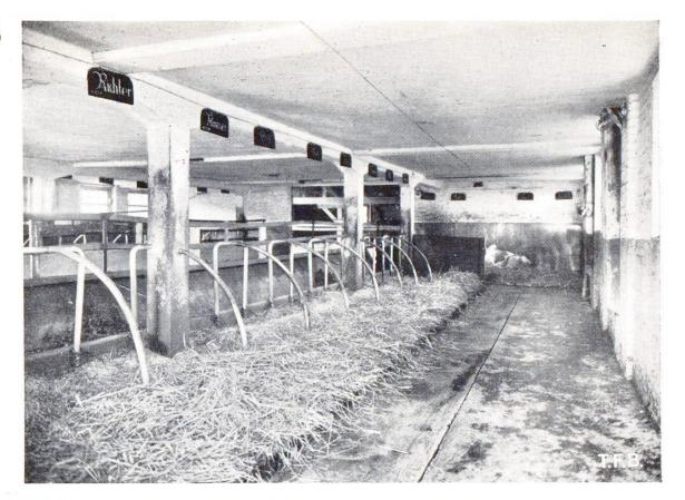
Abb. 2 Hallenstall mit Tiefkrippe, Kurzstand und armierter Hohlsteindecke
