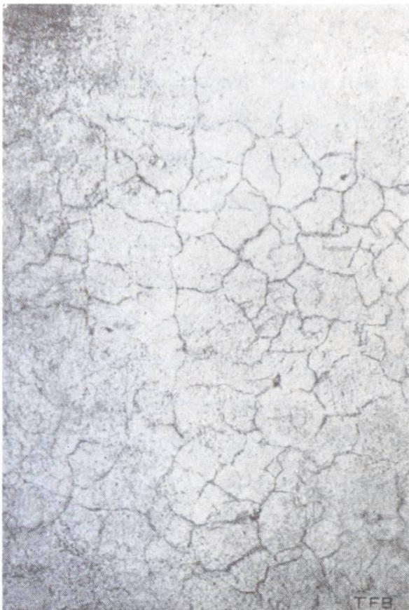
Abb. 2 Schwindrisse in Verputz, der mit einem Übermass an feinem Sand hergestellt wurde und ausserdem vorzeitig ausgetrocknet ist
