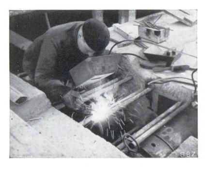
Abb. 4 Montagegelenk am Scheitel der Lorraine-Brücke der SBB in Bern (Spannweite 150 m). Verschweissen der übergreifenden Rundeisen nach dem Aufpressen des grossen Gewölbes. Unter den Armierungen ist ein festgestellter hydraulischer Kolben sichtbar. (SBZBd.116)
