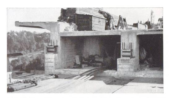
Abb. 7 Gelenkausbildung eines eingehängten Trägers. Fürstenlandbrücke bei St. Gallen. Rollenlager. (SBZ Bd. 118)
