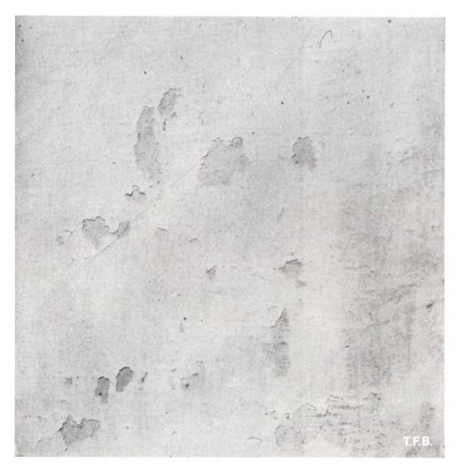
Abb. 3 Abblätterung von Fassadenanstrich, der mit einem ungeeigneten Zusatzmittel versetzt wurde
