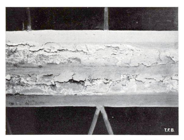
Abb. 6 Zersetzung und Abblätterung eines Spezialanstrichs auf einer Betonrippe
