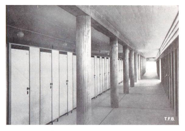
Abb. 8 Schwimmbad Olten. Innenansicht der Kabinenhalle. Befonbelag. Pfeiler, Unterzug und Decke in schalungsrohem Eisenbeton. Kabinenfront (Türen und Wandverkleidungen) aus Eternit
