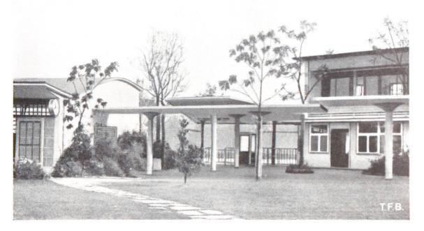
Abb. 7 Freibad Allenmoos, Zürich. Eingangspartie. Rohe Eisenbetonkonstruktionen. Freistehende Pilzdächer für die gedeckten Uebergänge. Links Garderobehalle mit gechwungenem Dach in Eisenbeton.
