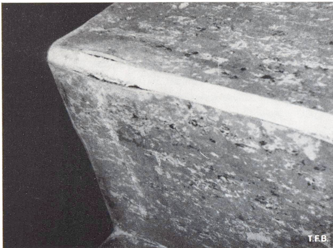
Abb. 1 Beginnende Zersetzung von Anticorodal-Leiste an Betontreppe.
