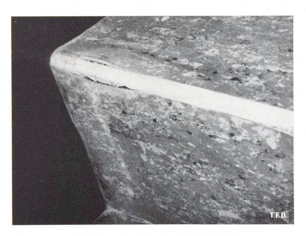
Abb. 1 Beginnende Zersetzung von Anticorodal-Leiste an Betontreppe.
