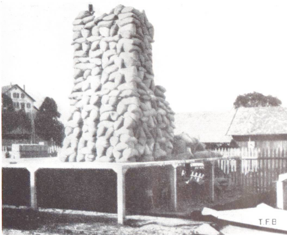
Abb. 5 Erstes Pilzdeckenversuchsmodell von Maillart 1908 (siehe Lit.)
