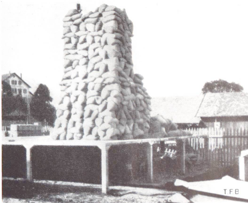
Abb. 5 Erstes Pilzdeckenversuchsmodell von Maillart 1908 (siehe Lit.)
