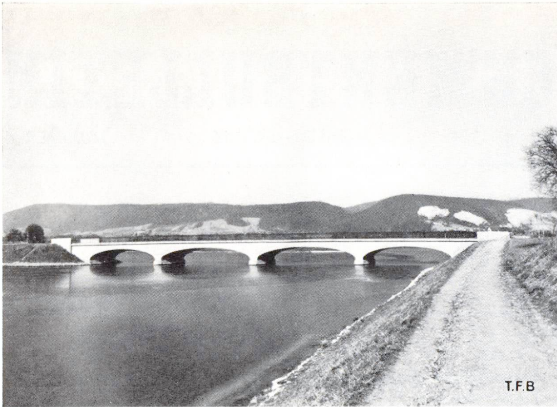
Abb. 1 Ergolzbrücke bei Augst
