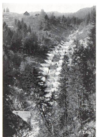
Abb. 6 Sperrentreppe in Beton, mit Natursteinverkleidung der Überfälle an der Mettenlaui in Giswil, Kt. Obwalden; Aufnahme von 1934. Tobeleinhänge heute vollständig von Gebüsch und Jungwald besiedelt
