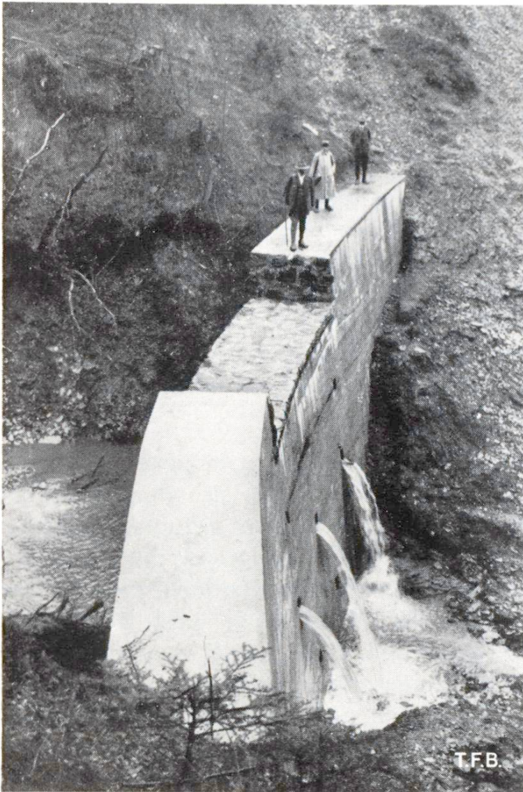
Abb. 5 Sperre in Beton mit Natursteinverkleidung des Überlaufes, kurz nach Bauvollendung; heute mit Geröll hinterfüllt; Trübbach bei Trübbach, Kanton St. Gallen
