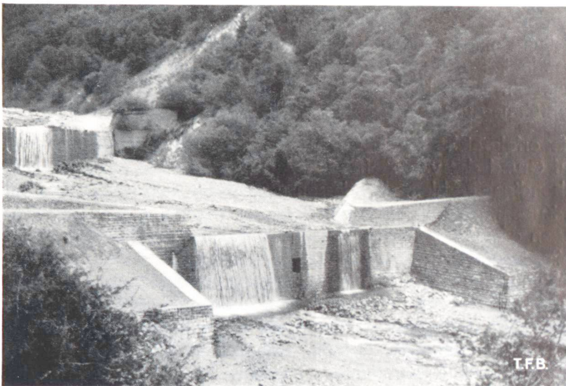
Abb. 4 Sperre aus Beton mit Natursteinverkleidung, mit deformierbaren Flankenanschlüssen, in bewegtem Gelände; Nollaverbauung bei Thusis
