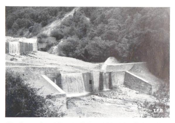
Abb. 4 Sperre aus Beton mit Natursteinverkleidung, mit deformierbaren Flankenanschlüssen, in bewegtem Gelände; Nollaverbauung bei Thusis
