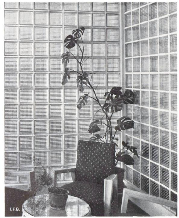
Abb. 6 Innenwände aus Glasbeton
