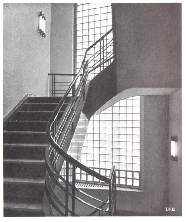
Abb. 5 Treppenhauswand aus Glasbeton
