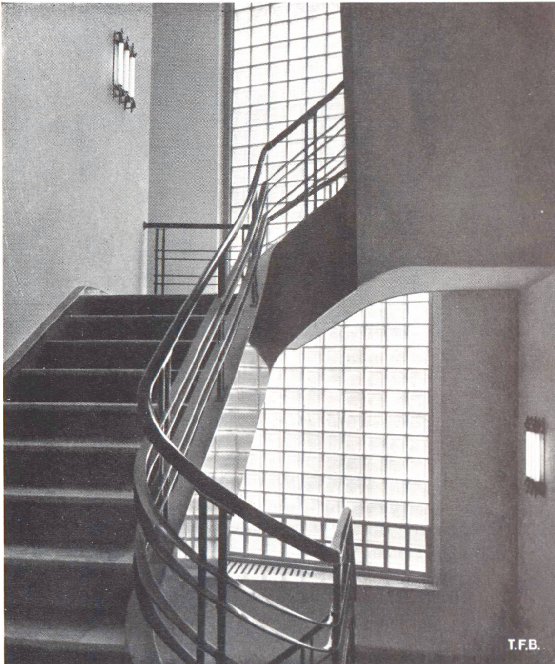
Abb. 5 Treppenhauswand aus Glasbeton
