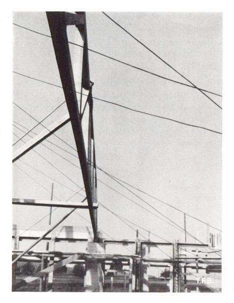
Abb. 5 Einzelbinder nach dem Aufrichten mit entfernter Arbeitsbühne
