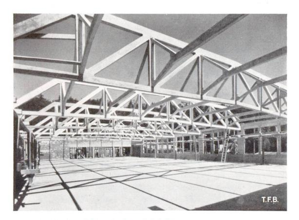
Abb. 8 Dachbinder und Längsriegel am 10. Arbeitstag
