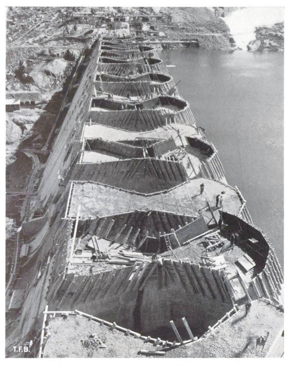
Abb. 5 Einseitige Steigschalungen beim Bau der Staumauer Lucendro
