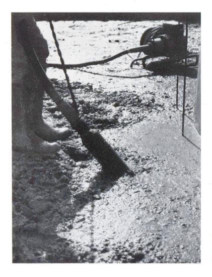
Abb. 2 Verdichten des in Abb. 5 gezeigten, erdfeuchten Staumauerbetons mittelst Nadelvibrator
