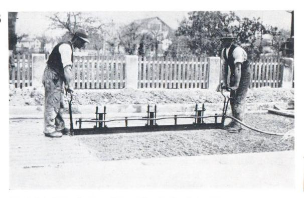
Abb. 8 Oberflächenvibration mit dem "Vibropil". Pressluftantrieb
