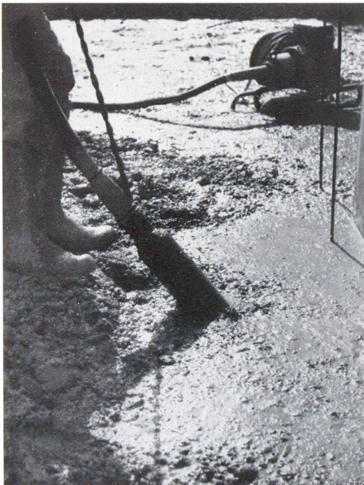
Abb. 2 Verdichten des in Abb. 5 gezeigten, erdfeuchten Staumauerbetons mittelst Nadelvibrator
