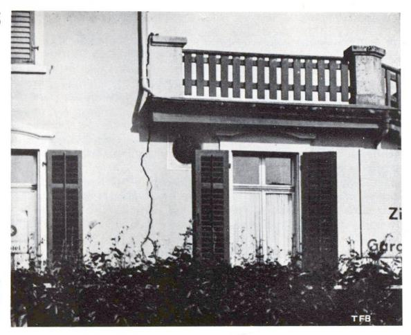
Abb. 4 Setzungsriss zwischen Hauptgebäude und Anbau
