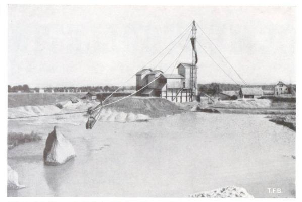
Abb. 1 Kabelbaggerbetrieb und Aufbereitungsanlage
