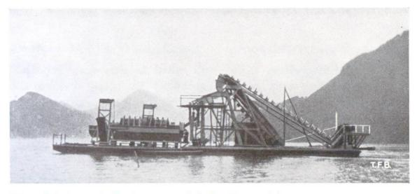
Abb. 2 Schwimmende Gewinnungs- und Aufbereitungsanlage
