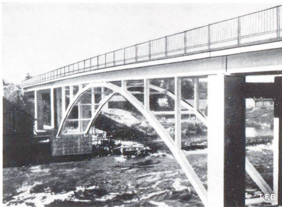
Abb. 4 Koskenniska-Brücke über den Kymifluss, Finnland. Versteifter Stabbogen von 40 m Spannweite. (Siehe Lit.)
