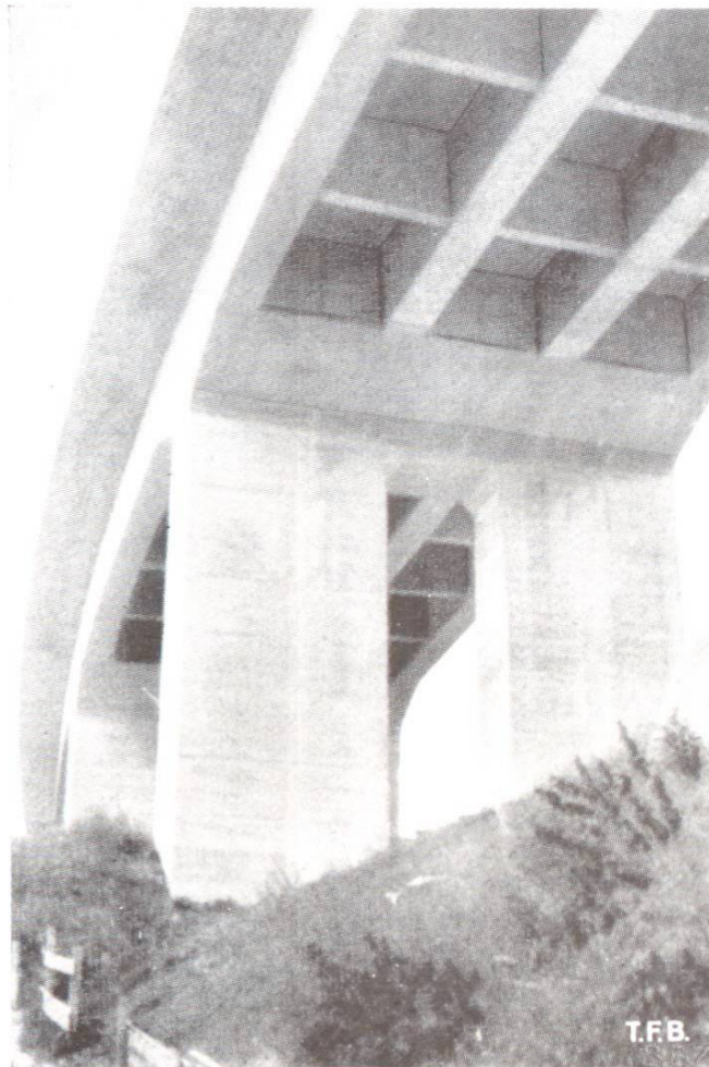
Abb. 5 Viadukt der 4-geleisigen neuen Lorraine-Linie der SBB in Bern, erbaut 1938/39. Rahmenbrücke mit torsionsfestem Pfeilerkopf und Trägerrost bestehend aus je einem Hauptlängsträger pro Geleise und Quertragwerk (Siehe Lit.)
