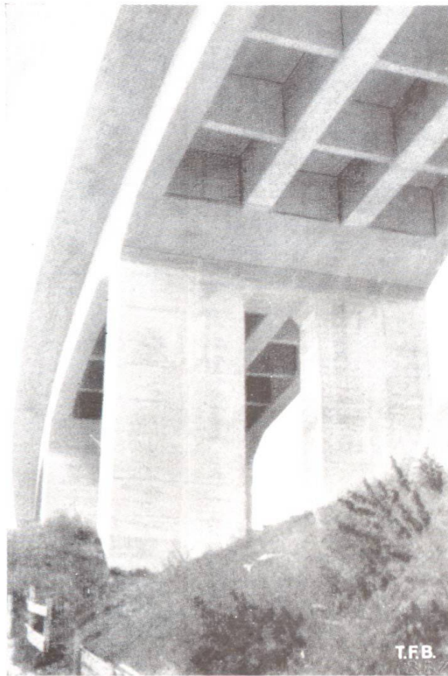
5 Abb. 5 Viadukt der 4-geleisigen neuen Lorraine-Linie der SBB in Bern, erbaut 1938/39. Rahmenbrücke mit torsionsfestem Pfeilerkopf und Trägerrost bestehend aus je einem Hauptlängsträger pro Geleise und Quertragwerk (Siehe Lit.)
