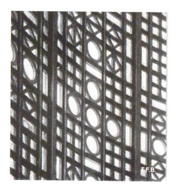
Abb. 2 Kirchenbau, Notre-Dame du Raincy, Eisenbetonkonstruktion, mit Aussenwänden aus verglasten Beton-Rippen-Elementen, erbaut 1921-22 von A. & G. Perret
