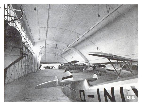
Abb. 6 Sportflugzeug-Hangar in Eisenbeton als dünnwandige Schale konstruiert von Dyckerhoff & Widmann
