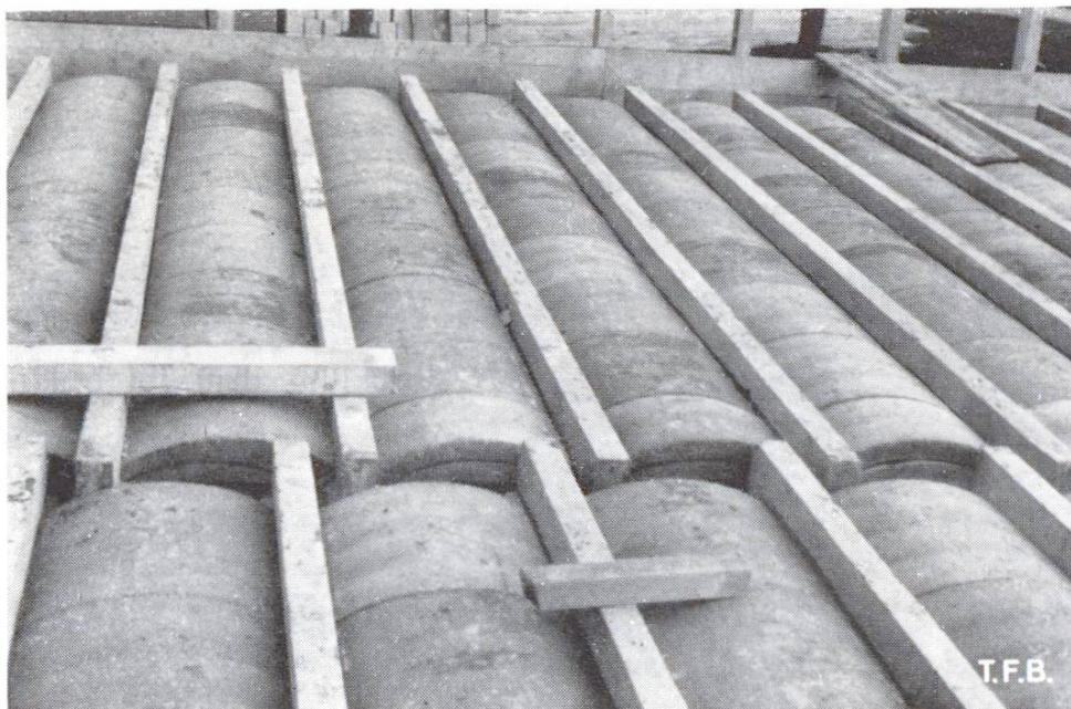
Abb. 3 Deckenkonstruktion aus vorgespannten Fertigbalken und Betonhourdis
