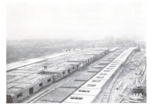
Abb. 2 Herstellung von ganzen Hauswänden
