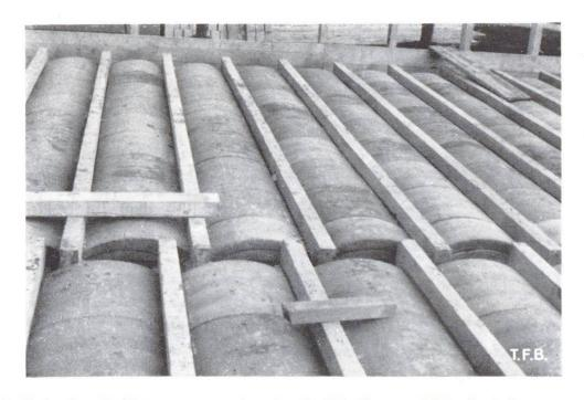
Abb. 3 Deckenkonstruktion aus vorgespannten Fertigbalken und Betonhourdis
