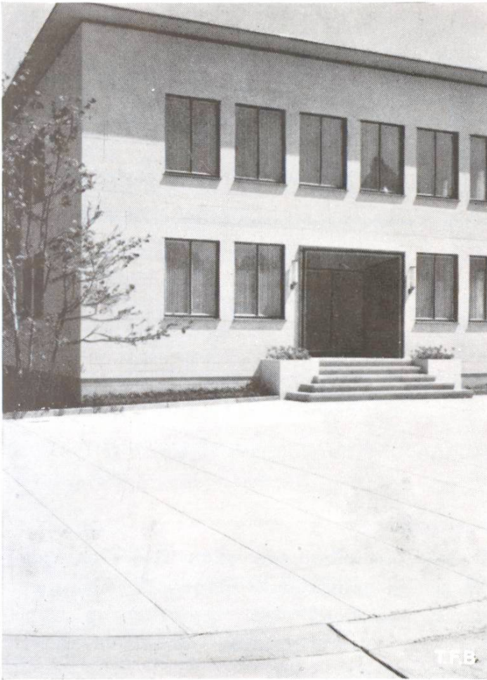
Abb. 1 Haupteingang zur T. F. B.
