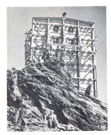
Abb. 2 Hölzerne Ummantelung eines zu betonierenden Bauwerks (Meteorologisches Observatorium Jungfraujoch 3570 m ü. M.)
