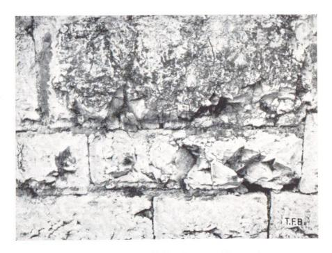
Abb. 3 Frostzerbröckelung von rissigen Kalksteinen am Bauwerk
