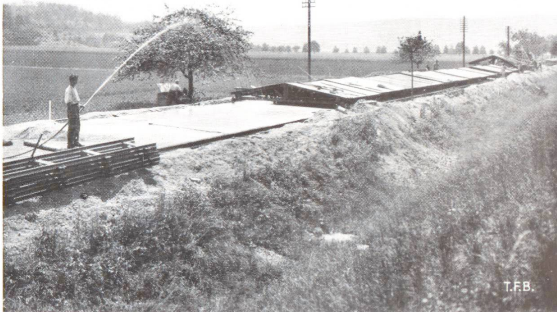
Abb. 3 Schutz einer frisch erstellten Betonfahrbahn gegen Sonnenbestrahlung, Regen oder mechanische Beschädigung mittelst fahrbarer Dächer. Links Spritzen eines frisch erhärteten Feldes mit Wasserstrahl. Am Rand links ist noch die Überdeckung mit feuchtem Sand sichtbar.
