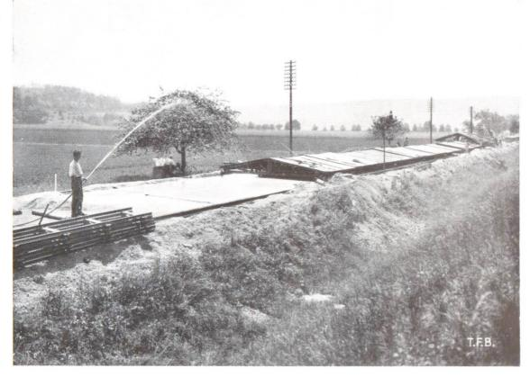
Abb. 3 Schutz einer frisch erstellten Betonfahrbahn gegen Sonnenbestrahlung, Regen oder mechanische Beschädigung mittelst fahrbarer Dächer. Links Spritzen eines frisch erhärteten Feldes mit Wasserstrahl. Am Rand links ist noch die Überdeckung mit feuchtem Sand sichtbar.
