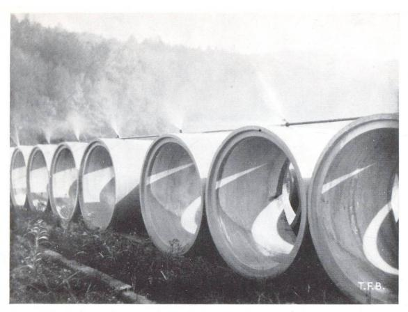
Abb. 4 Cementwaren werden während mehrwöchiger Lagerung feucht gehalten. Selbst feine Risse können bei einer derartigen Nachbehandlung ausheilen.
