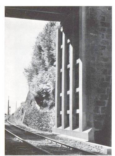
Abb. 9 Sicherung eines ge= mauerten Brücken= Widerlagers
