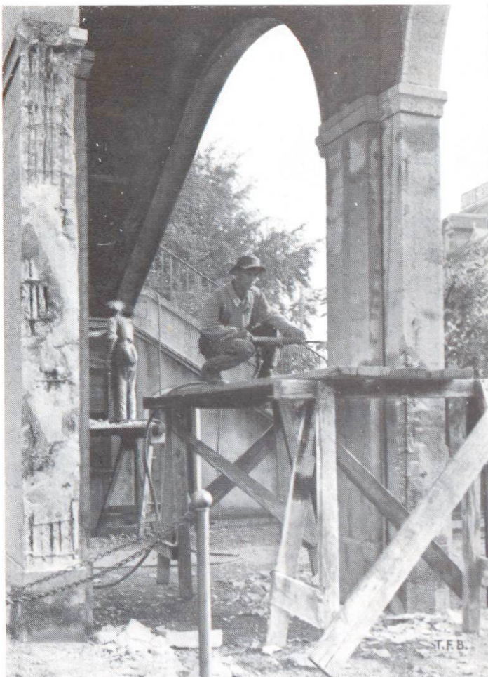
Abb. 6 Instandstellung einer Eisenbeton-Passerelle
