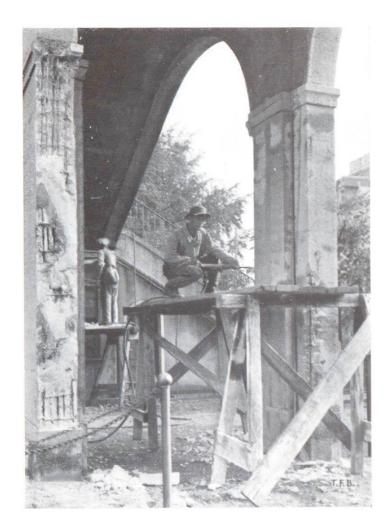
Abb. 6 Instandstellung einer Eisenbeton-Passerelle
