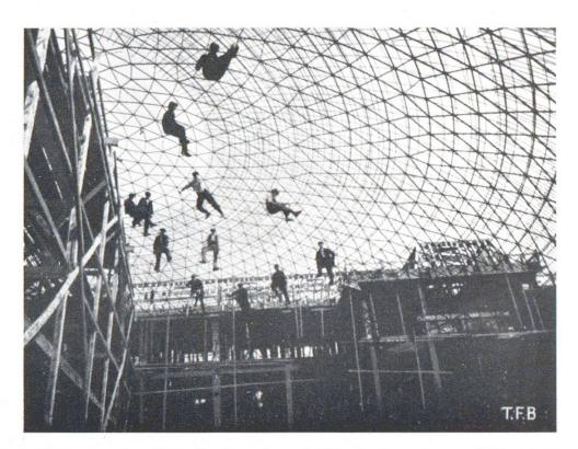
Abb. 4 Stahlnetz einer Zeiss-Dywidag-Kuppel. Die je 60 cm langen Stäbe sind in den Knotenpunkten starr verbunden.
