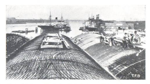
Abb. 3 Flache Schalengewölbe im Bau. Links Armierung. Rechts Aufbringen des Betons.
