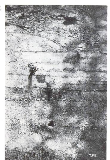
Abb. 3 Die Folgen der Entmischung: Kiesnester, namentlich in den unteren Lagen der einzelnen Schüttungen
