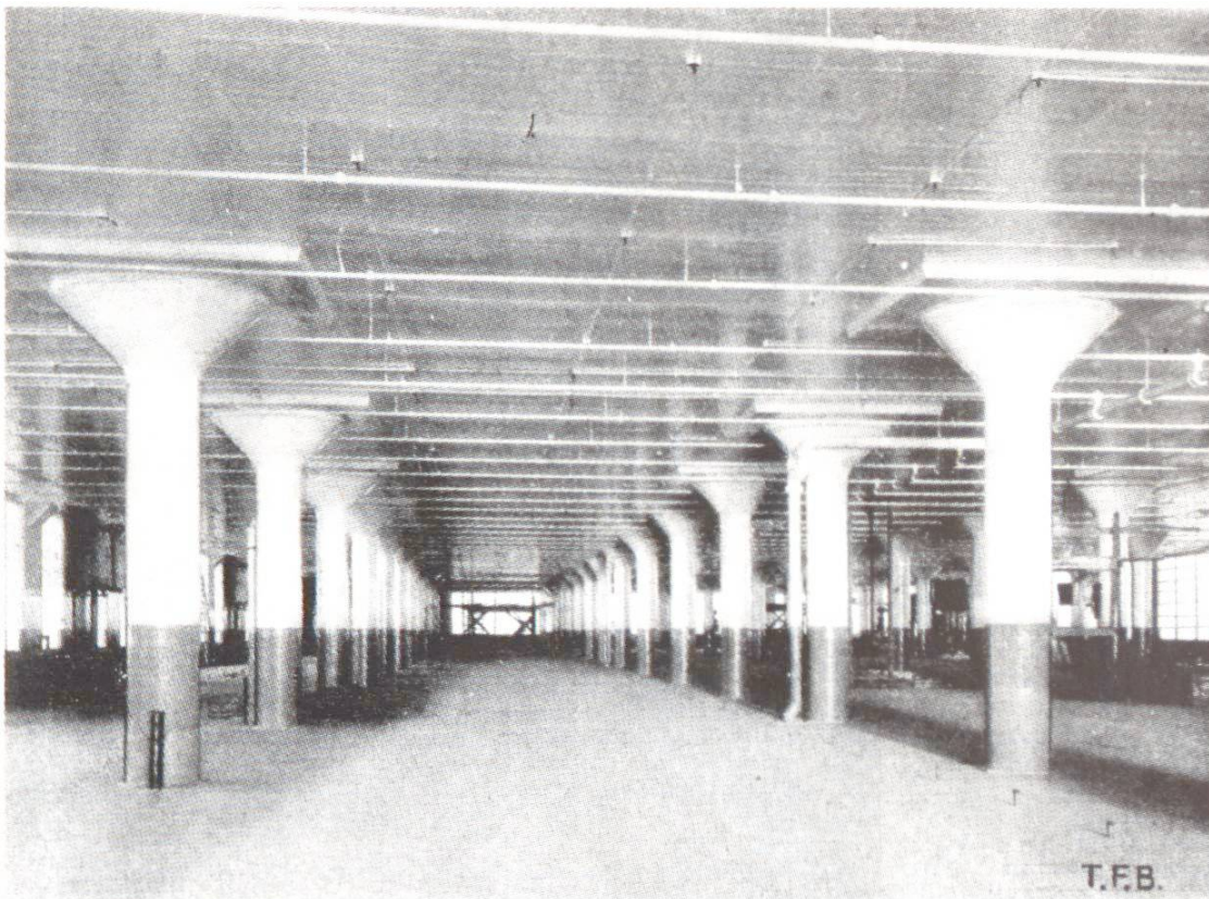
Abb. 5 Pilzdecke in grossem Warenhaus (U.S.A.)
