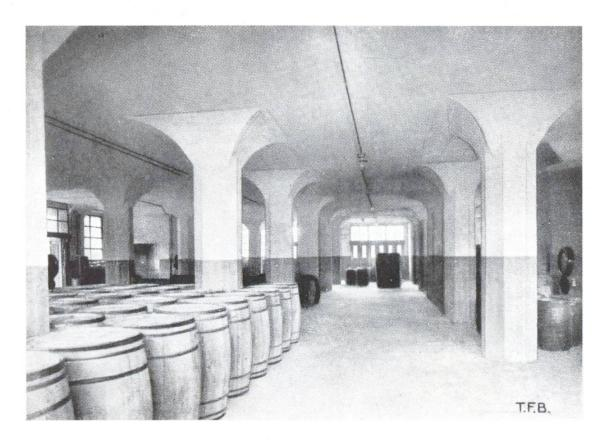
Abb. 7 Pilzdecke in Lagerhaus einer chemischen Fabrik
