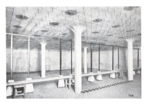
Abb. 3 Untersicht einer Versuchs-Pilzdecke mit Messpunkten
