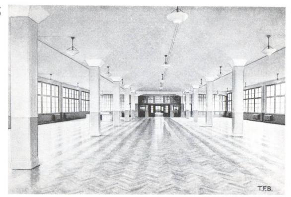
Abb. 6 Pilzdecke (1926) in einer Maschinenfabrik
