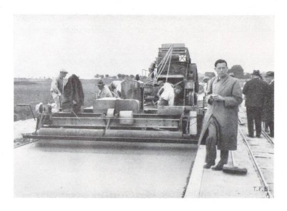
Abb. 7 Strassenfertiger mit Vibrator und selbstfahrendem Zwangsmischer auf der Baustelle Solothurn-Selzach
