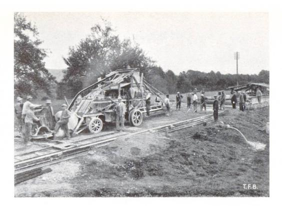
Abb. 6 Selbstfahrender Strassenbetonmischer mit Transportband. Trommelinhalt 500 Liter
