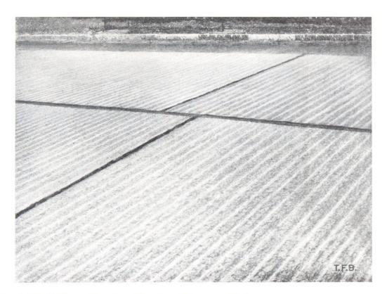
Abb. 4 Oberfläche mit grober Rippelung für grosse Steigungen
