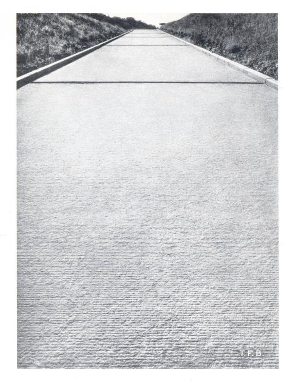
Abb. 3 Oberfläche mit feiner Rippelung für geringe Steigungen
