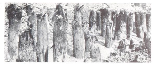
Fig. 5 Abgefaulte, hölzerne Pfahlköpfe, Zersetzung der über dem Grundwasserspiegel liegenden Partien (Phot. Raymond, NYC)
