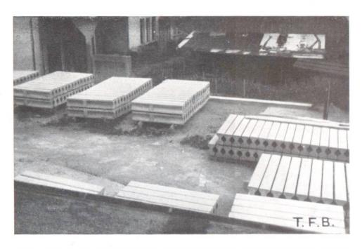
Abb. 4 Betonfertigteile (Mastensockel) mit vorgespannten Stahldrahtlitzen armiert
