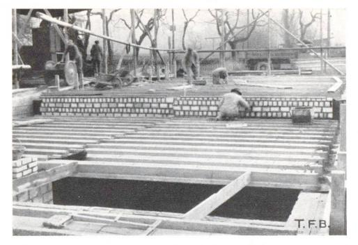
Abb. 6 Hourdisdecken mit vorgespannten Fertigbalken im Einbau
