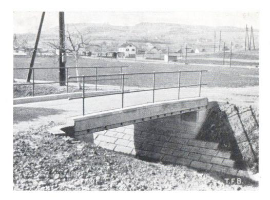
Abb. 3 Strassenbrücke in vorgespannter Eisenbetonbauweise, armiert mit vorgespannten Stahldrahtlitzen
