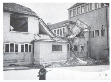
Abb. 6 Volltreffer in Eisenbeton - Hohlsteindecke. Einsturz der Decke durch Herausdrücken einer Auflagemauer
