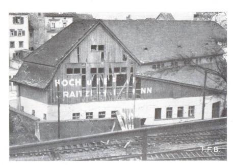
Abb. 4 Wirkung des "Sogs" auf Leichtkonstruktion
