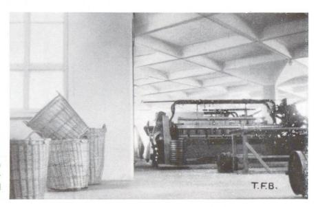
Abb. 10 Eisenbetondecke unmittelbar unter dem Brandherd nach dem Brand
