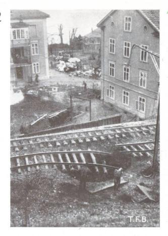
Die dicht vor dem Haus einschlagende Sprengbombe hat bei der ungenügenden Versteifung der Wände durch die Holzbalkenlagen durch die Sogwirkung das ganze Gebäude zum Einsturz gebracht.
