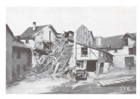
Abb. 2 Explosionswirkung auf Wohnhaus aus Bruchstein und Zie-, gelmauerwerk
