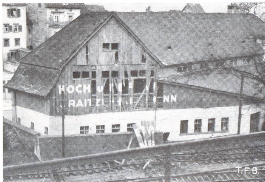
Abb. 4 Wirkung des „Sogs“ auf Leichtkonstruk- tion
