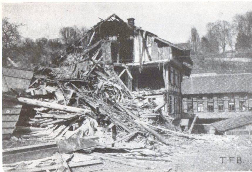
Abb. 3 Explosionswirkung auf Riegelbauwerk
