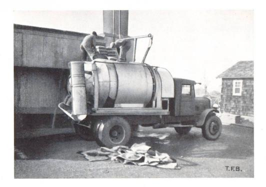
Abb. 6 Transportmischer 3 m³. Nach dem Zuwägen des Sandes und Kieses wird der Cement zugegeben und Mischwasser unter Verschluss eingefüllt. Kurz vor Erreichen der Baustelle wird der Mischer in Gang gesetzt
