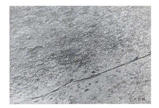
Abb. 6 Uebermässig starke Abnützung eines Cementbelags infolge Verwendung zu nassen Mörtels für die Abriebschicht
