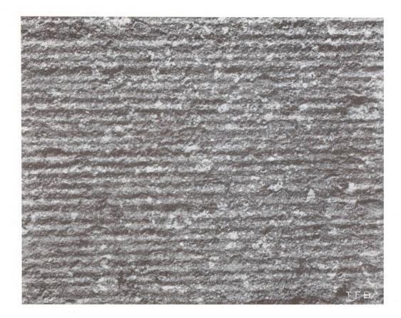
Abb. 5 Bearbeitung des Betons durch Riffelschlag
