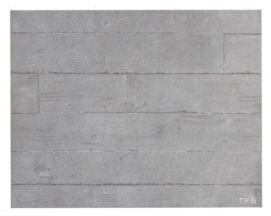
Abb. 1 Sichtbeton aus gehobelter Schalung, mit Mineralfarbe gestrichen
