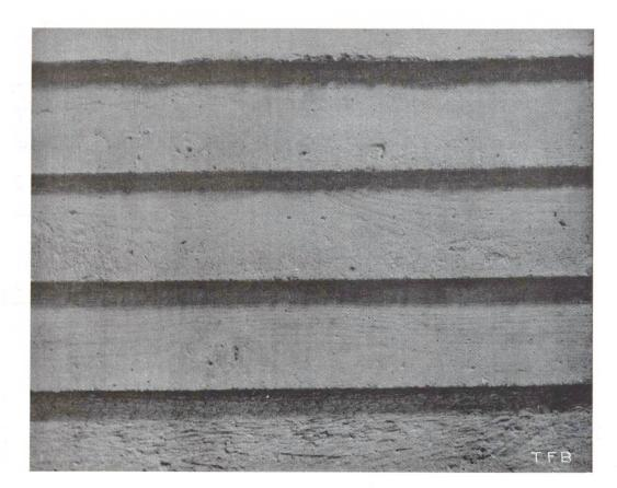
Abb. 2 Beton aus überlappter Schalung, roh belassen
