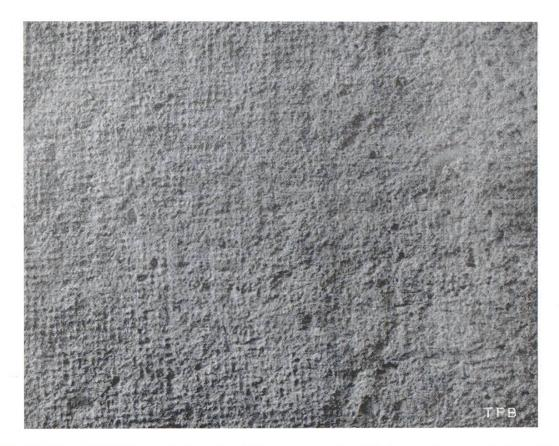
Abb. 3 Betonsichtfläche, erhalten durch Bespannen der Schalung mit vorgenässtem Jutegewebe
