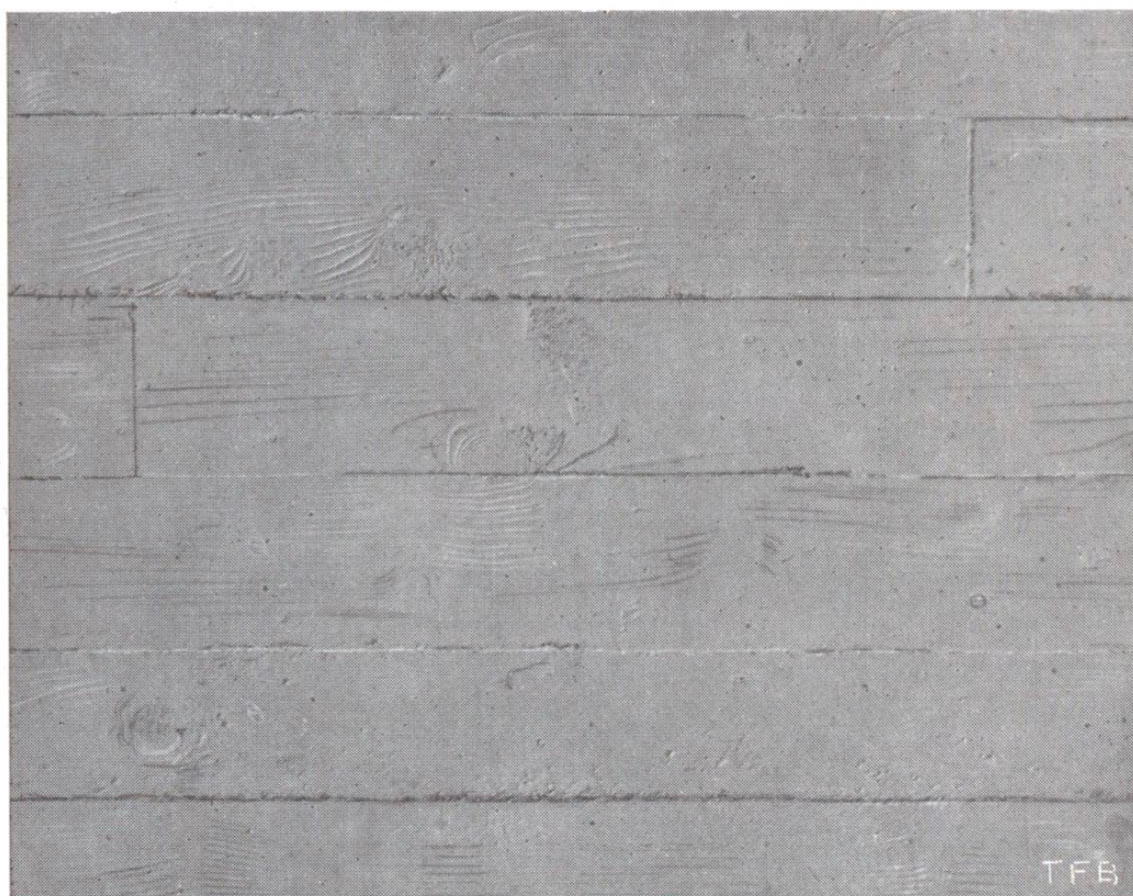
Abb. 1 Sichtbeton aus gehobelter Schalung, mit Mineralfarbe gestrichen
