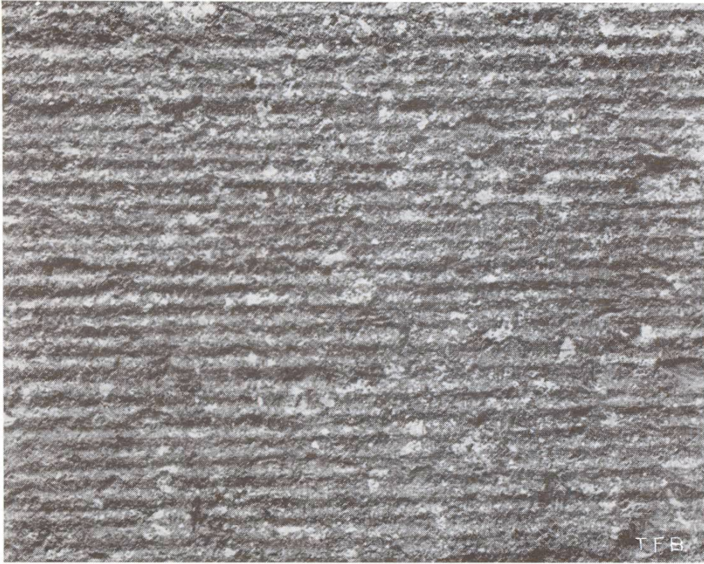
Abb. 5 Bearbeitung des Betons durch Riffelschlag
