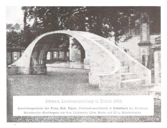
Abb. 3 Betonbrücke an der Landesausstellung 1883
