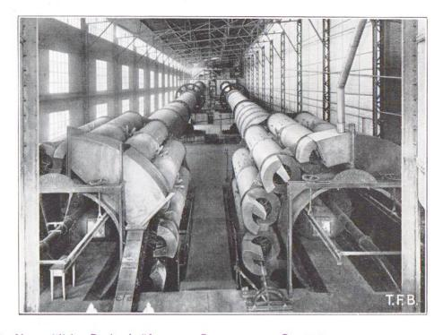
Abb. 2 Neuzeitliche Drehrohröfen zum Brennen von Cement
