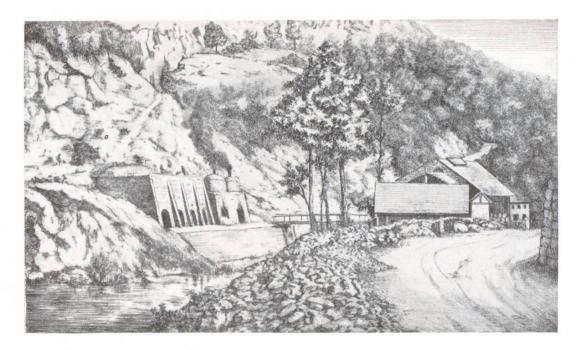
Abb. 1 Schachtöfen zum Brennen von Bindemitteln 1840
